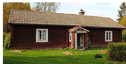
Längsidan med ingången (A) vätter mot sydost.
