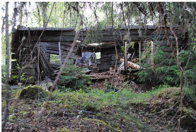
Resterna av Lövens stuga på Rävholm öster om Fäntjärn (ca 1762). Väggen där dörren har varit har delvis sågats bort, antagligen för att avlägsna de tuktade stenarna från den öppna spisen.
