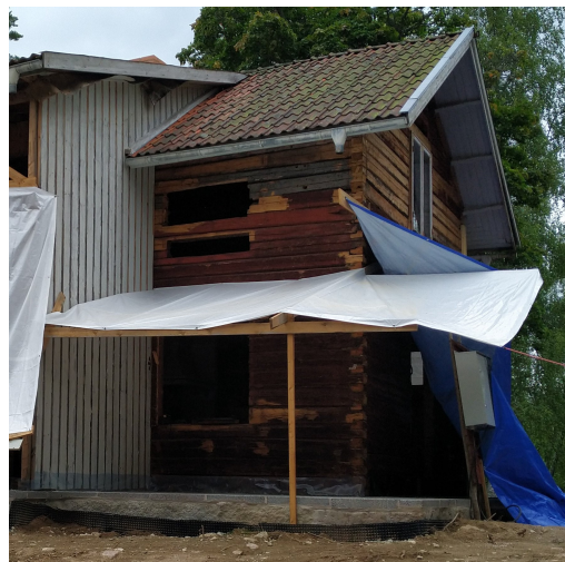
Timret från 1912 års ombyggnad har uppenbarligen aldrig varit tänkt att vara synligt, och i samband med att den då brädslogs ser knutskallarna ut att ha sågats av.
