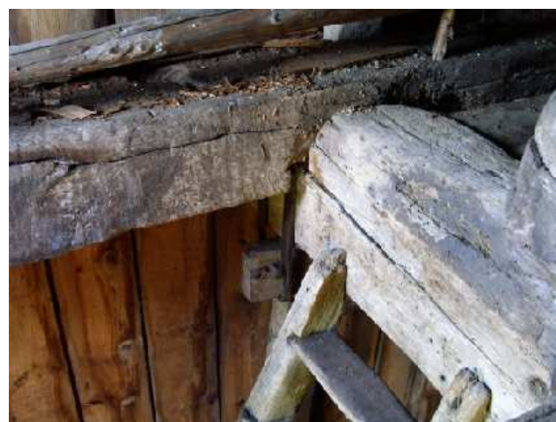
Kp09. Mellanbjälkarna vilar i denna kvarn ovanpå hjärstocken istället för att vara intappade.
