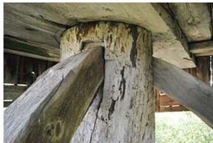
Stubbe, stöttor och brostockar. Notera barkresterna på både stubbe och stöttor - ett indicium på att kvarnen inte flyttats.
