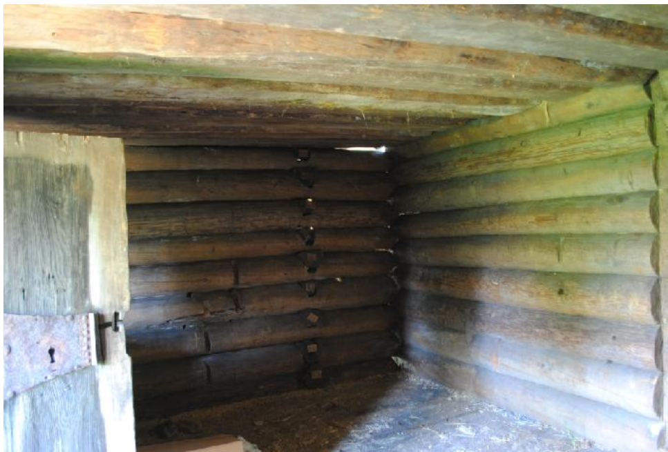
Parbodens mellanvägg saknas. Väggarna E och Cb och ändarna av de anslutande stockarna i Ca syns på bilden.
