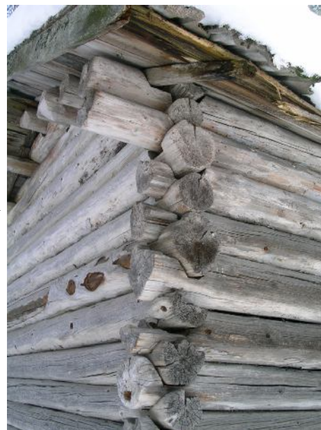
Knutkedjan B-C och några takåsar. Lägg märke till de stora brandljuden i stock C13.
