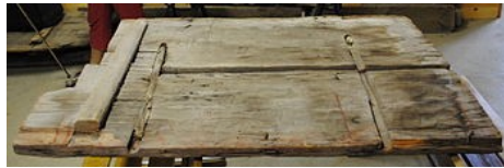
Dörren, baksidan med de blottade kähphålen
