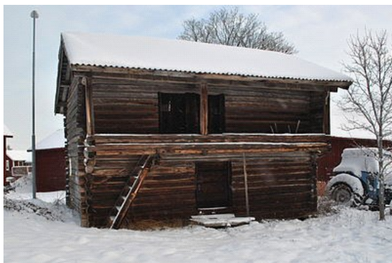
Loftboden ursprungligen byggd ca 1559.
