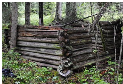
Lada 4: Resterna efter en enkel rundtimmerlada från 1741.
