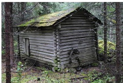
Lada 3: Rundtimmerlada med långdrag och dubbelhaksknutar från 1799.
