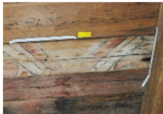
Parti av underlagsbrädor från norra långsidan. Obehandlad räfflad trådspik håller 1930-talsspånen och man kan se spikhål från en omgång äldre spån. Underlagsbrädorna är återanvända från gamla kyrkan. De dekorerade är daterade till 1660-tal och således rivningsvirke från gamla kyrkan, och måste därför vara ditsatta för det ursprungliga spåntaket, alltså tidigt 1770-tal.
