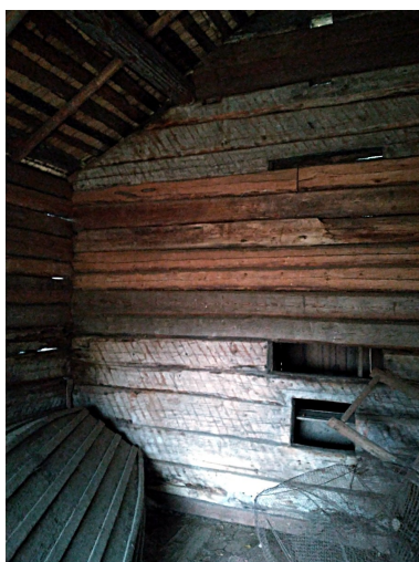
Stugtimret har varit klinat på ett diagonalt ribbverk.
